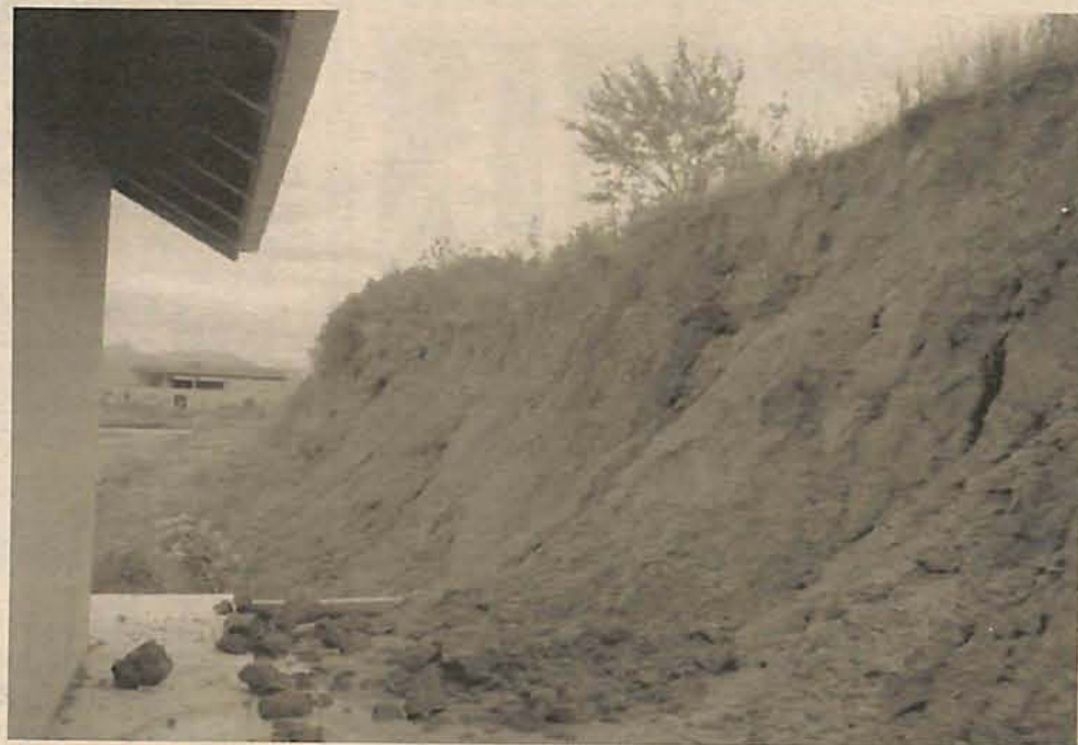
A força das águas provocou desbarrancamento e infiltrações no prédio da PM
