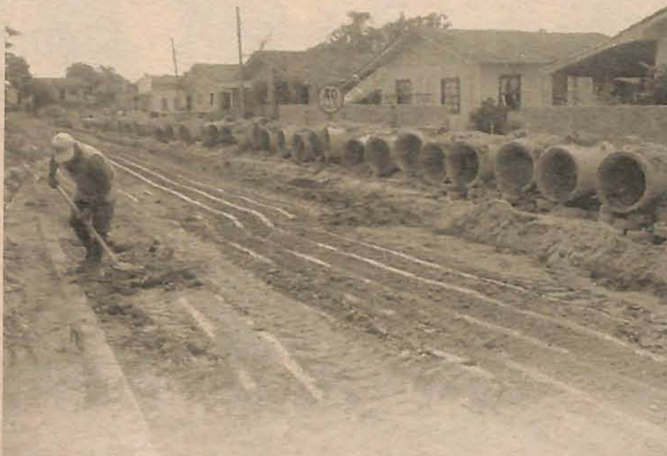
Investimentos devem reduzir a incidência de alagamentos na localidade
