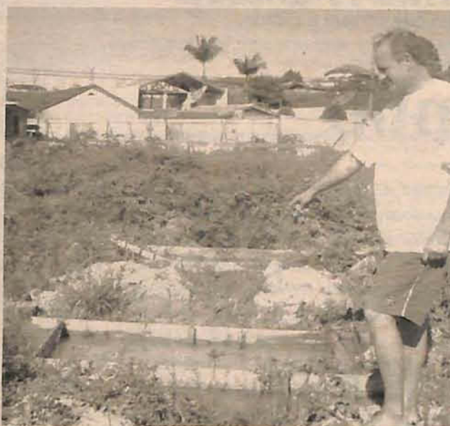
Obra deve ser reiniciada em breve
