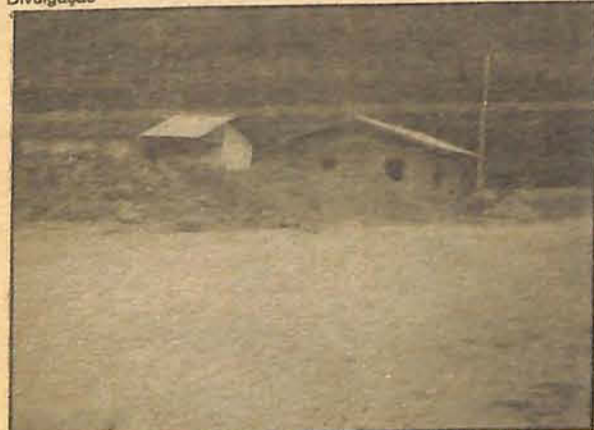
Acúmulo de barro impede acesso à residência
