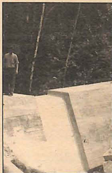
Barragem da ETA do Barracão
