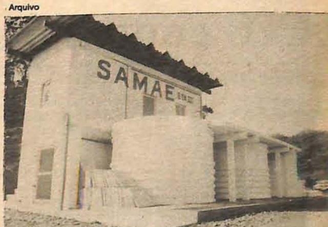
ETA de Belchior foi construída em pré-moldados
