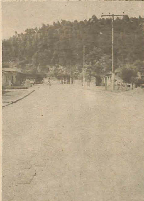
O calçamento na localidade de Pedra de Amolar estende-se por 1.800 metros, totalizando 8.200 metros quadrados
