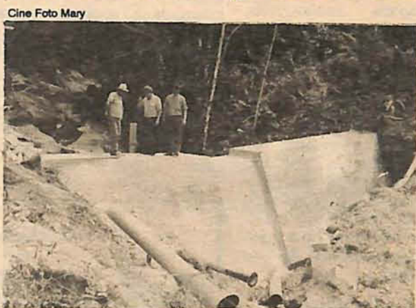
Barragem da ETA de Barracão já foi concluída
