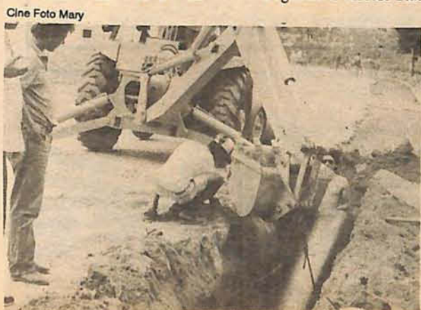
Adutora da ETA-centro possui 800 metros de extensão
