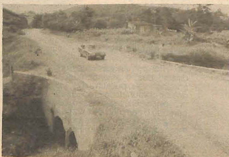
Na divisa com Gaspar, outra ponte de concreto.
