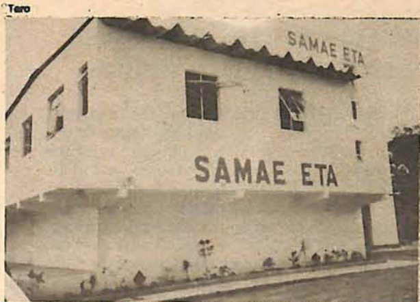
Capacidade da ETA-1 aumentou para 83 litros/segundo
