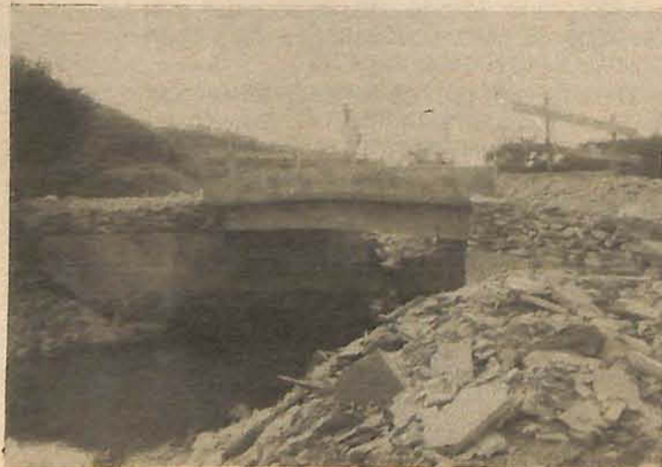
Ponte em concreto na localidade de Fruteira
