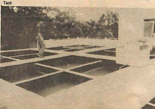
Novos floculadores foram construídos
