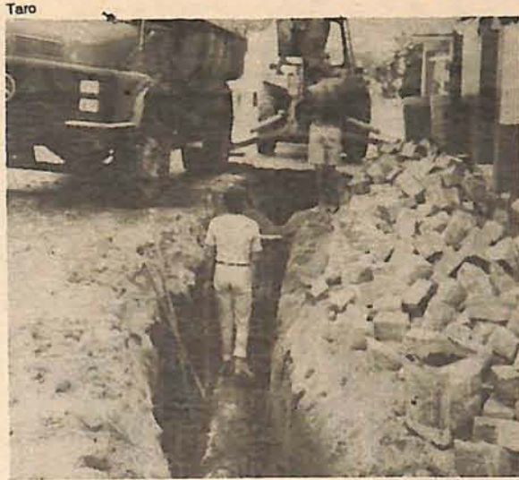
Tubulação vai impedir alagamento de residências
