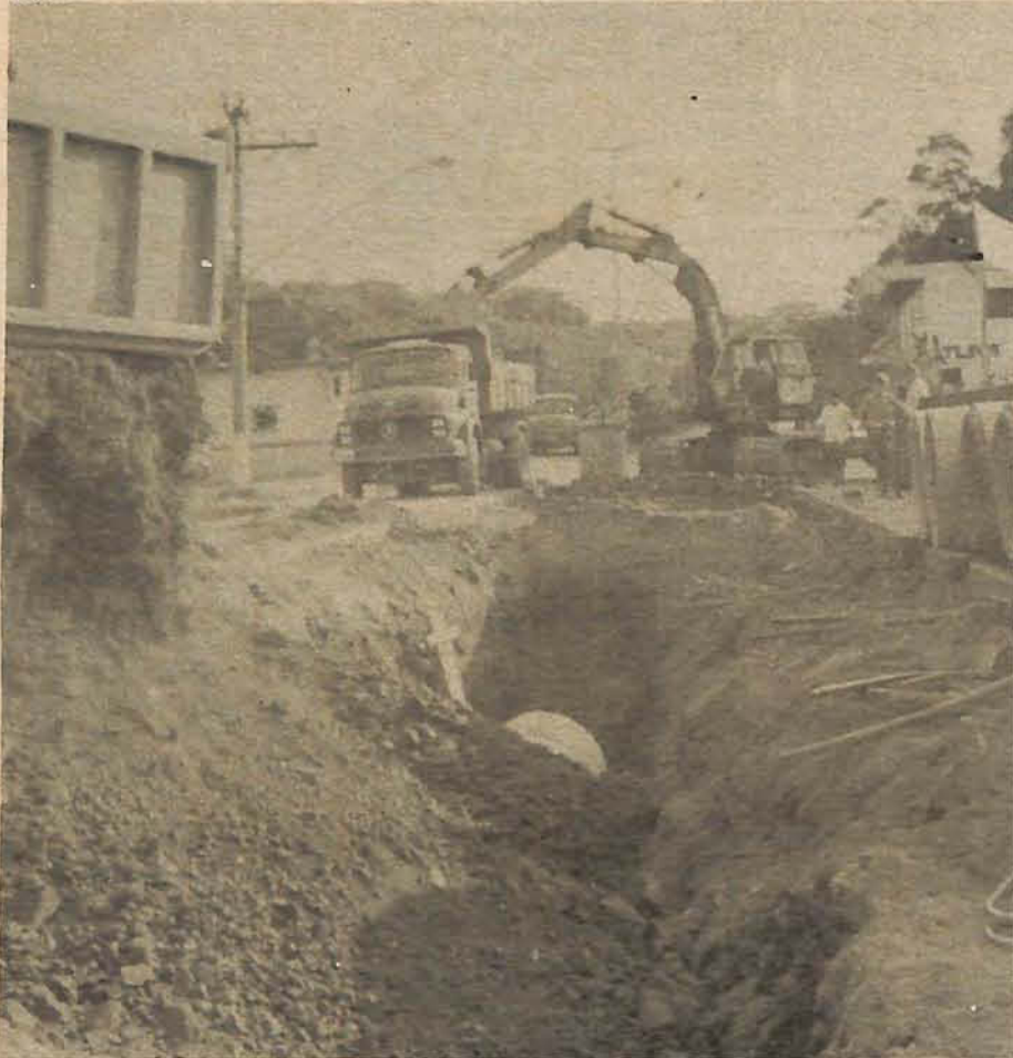
20 localidades receberam nova tubulação de esgoto pluvial
