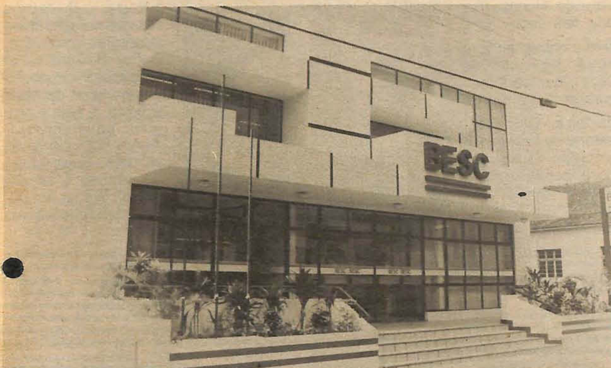
Com linhas arquitetônicas, nova agência vai garantir maior comodidade e segurança para clientes e funcionários
