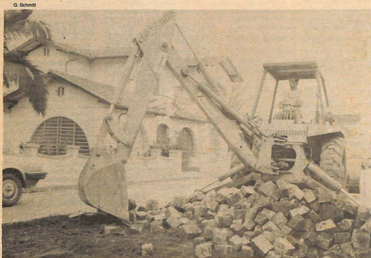
Obra completa do contorno vai ser concluída em março de 93. Asfalto cobrirá os paralelepípedos.
