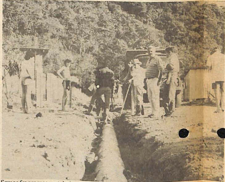
Samae fez reparos na tubulação de esgoto no Bela Vista
