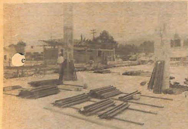
Cobertura do Terminal Fonte já está em fase final
