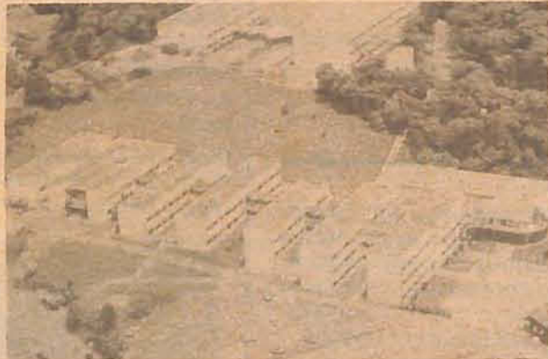
Serão construídas 26 novas salas e novos espaços
