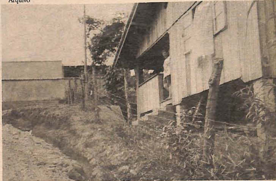
Rua da Comunidade Nova Esperança: falta esgoto, manutenção da via e pavimentação
