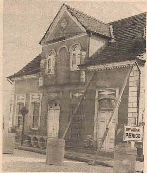
Falta de conservação da casa motivou desabamento
