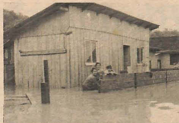
Casa totalmente alagada na região de Sertão Verde
