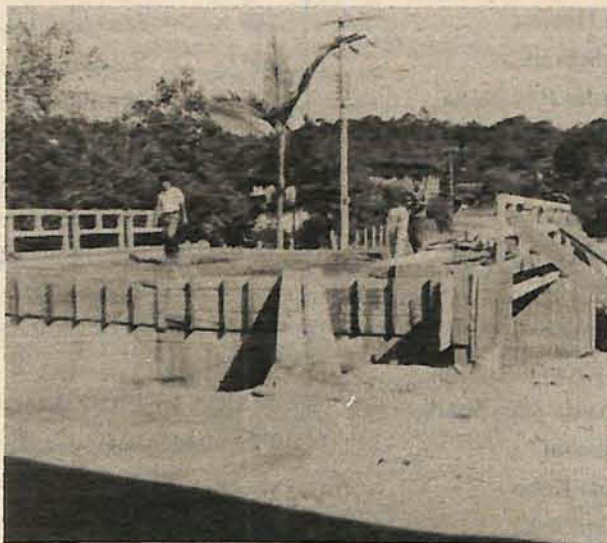
Ponte na rua Johann Maul, já liberada ao tráfego
