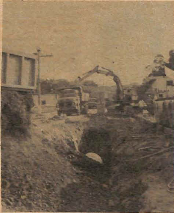
A tubulação foi acrescentada em mais de 700 tubos
