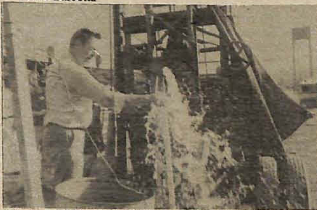
Na rodoviária, Sasse visitou o poço artesiano
