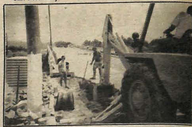
Obras da adutora (sobre a ponte), já foram pagas
