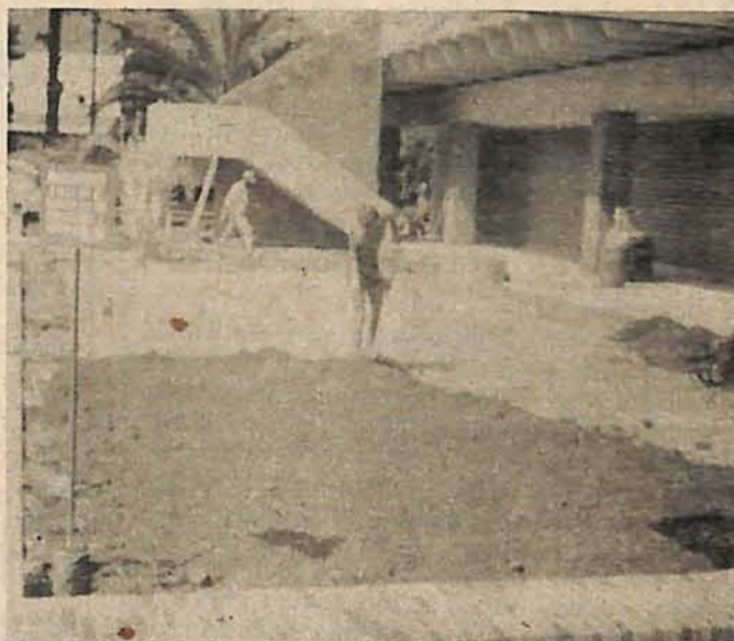
O ritmo dos trabalhos de construção estão dentro do cronograma previsto
