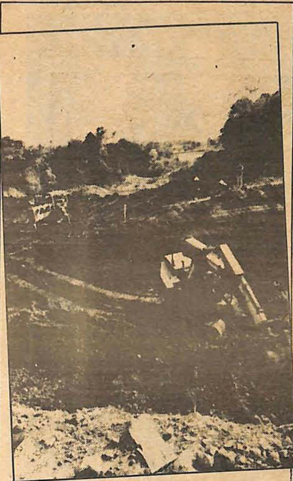
Em Pomerode, obras do contorno Leste.
