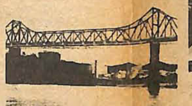
A Ponte Metálica foi restaurada.
