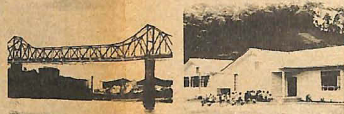
A Ponte Metálica foi restaurada.
