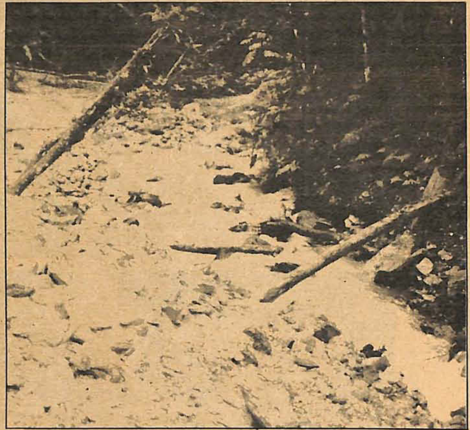
Uma barreira sobre o ribeirão Gaspar Grande formou um lago artificial de 15 metros de profundidade
