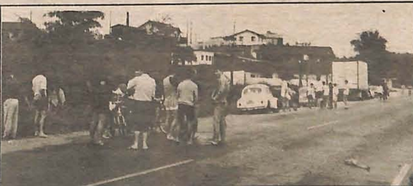
Na rodovia, ao lado do loteamento, curiosos e moradores ficam esperando que o bueiro dê vazão às águas
