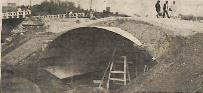
tado em camadas de 15 centímetros, iguais nos dois lados do túnel, para não haver tensões diferenciadas na estrutura.
