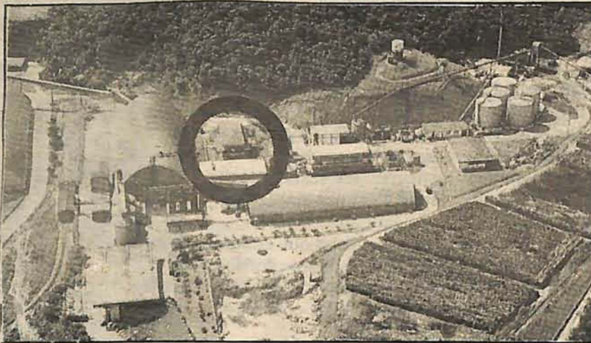
Complexo Industrial da Ceval em São Francisco do Sul. No círculo o local onde se deu a explosão
