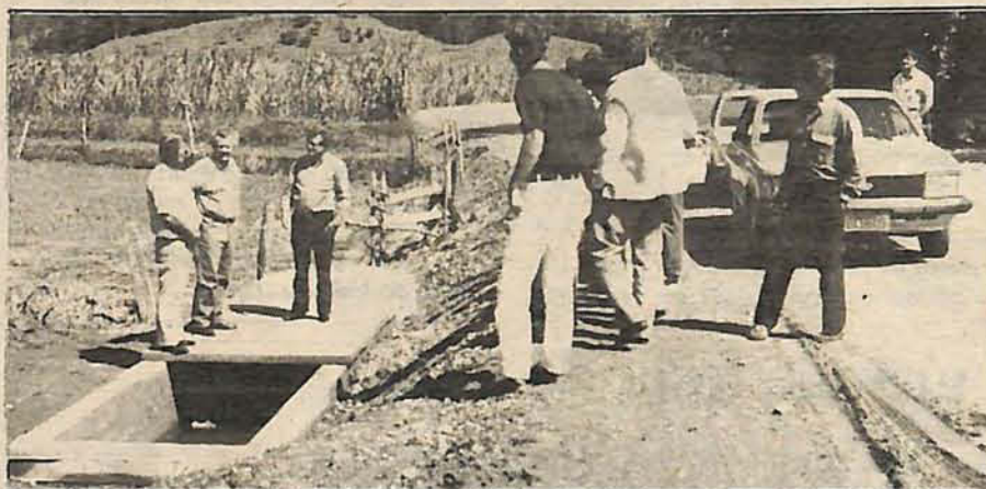
Obra realizada pela prefeitura no Arraial Baixo. Retificação de valas e tubulação para controle a canalização de água para as lavouras de arroz.
