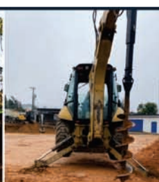
Escavação de brocas diâmetro e profundidade até 6 metros
