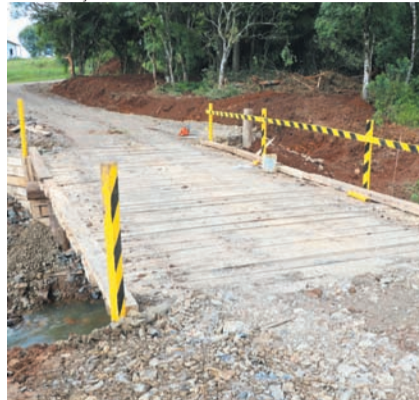
Pontes que dão acesso ao loteamento Tabalipa foram substituídas
