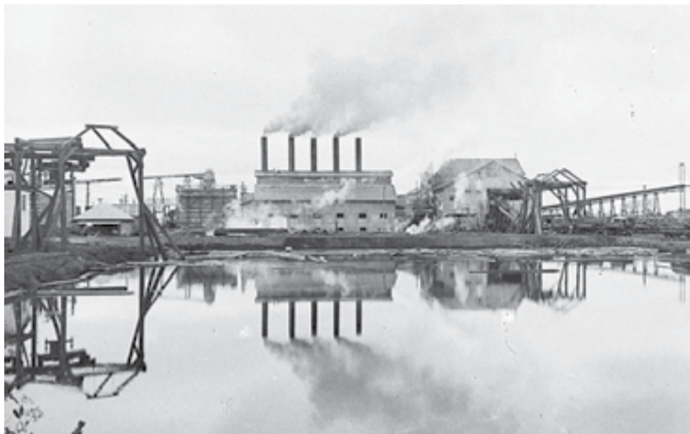
Nos anos 1930, parte do complexo industrial da madeireira Lumber, na vila de Três Barras.
