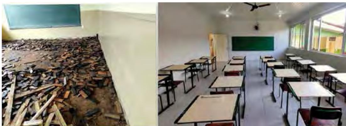
Em seis salas de aula, todas as lâmpadas fluorescentes, foram substituídas por lâmpadas de led, com utilização de recursos próprios da escola, na ordem de R\$ 3,5 mil, incluindo a mão-de-obra. Foram reformadas com piso cerâmico, novas janelas com esquadrias em alumínio
