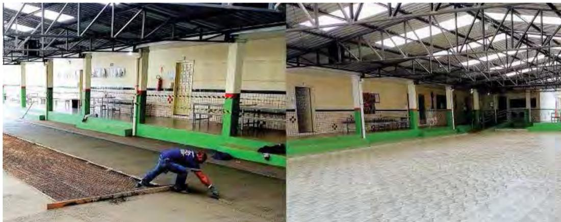
**Em junho deste ano, foi realizada a reforma completa de 450 m2 de piso do pátio com uma camada de asfalto (contra-piso) revestido com cerâmica. Por ser um espaço amplo e aberto, o espaço foi utilizado durante a pandemia, como refeitório para a merenda escolar, e, ainda servindo cerca de 150 refeições por dia.**
