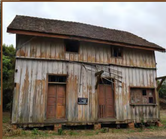
Restaurante antes de iniciar a restauração
