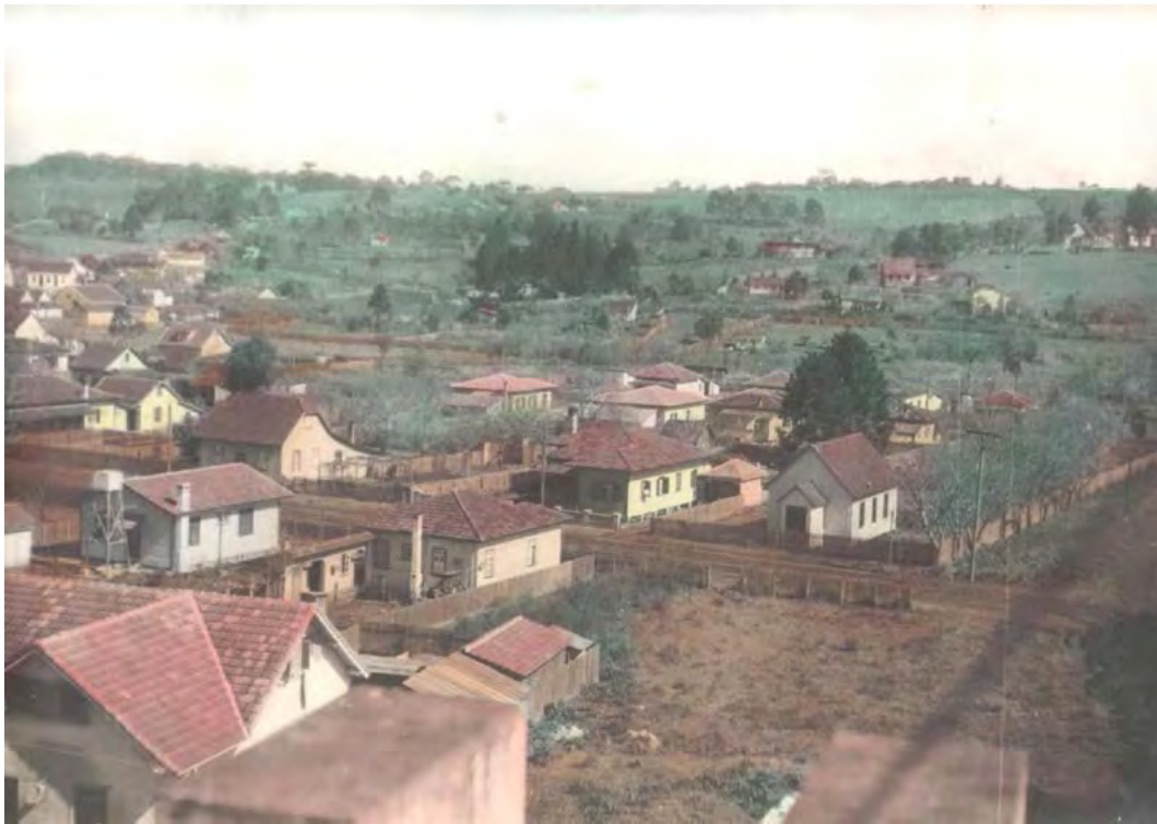
Foto de Curt Uhlig de 1953 mostrando o início da Rua Coronel Albuquerque e, ao fundo, parte dos bairros Sossego e Jardim Esperança ainda bem despovoados.
