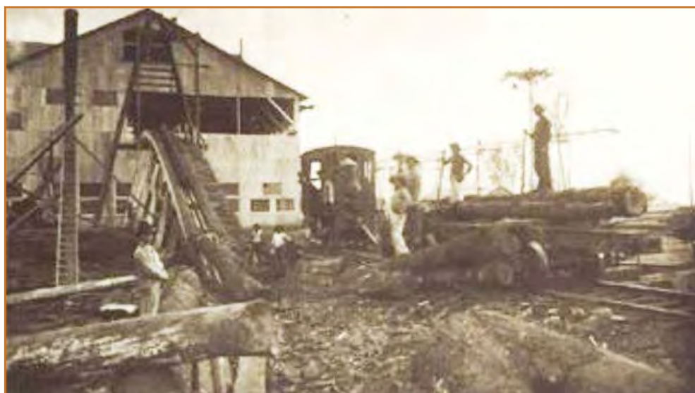
A serraria com sua esteira mecânica e a pequena locomotiva de transporte
