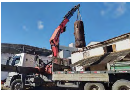
Foi necessário um guindaste para retirar as caldeiras do local
