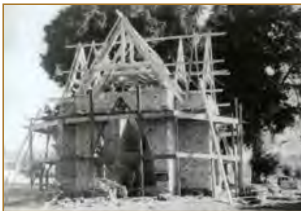
Capelinha em construção.
