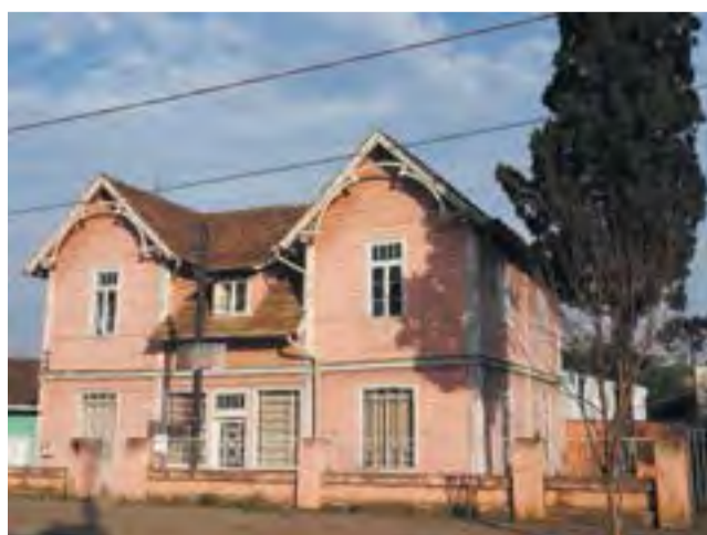
Casarão que ficava na rua Coronel Albuquerque, no centro, e foi demolida há pouco tempo.
