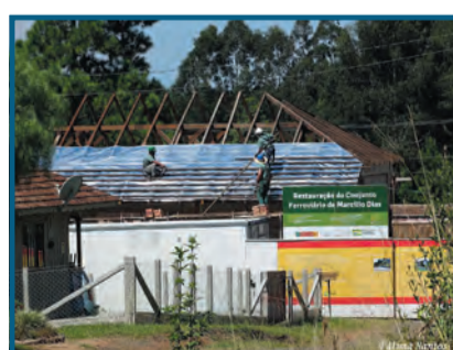
Antigo armazém em 23 de fevereiro de 2020.
