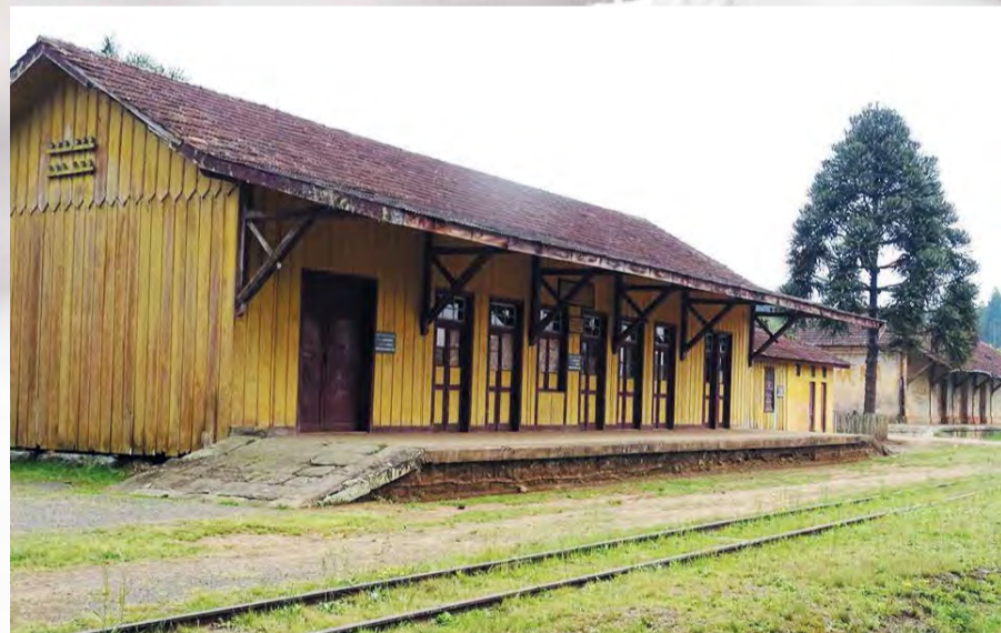
Estação ferroviária de Marcílio Dias antes do início da restauração
