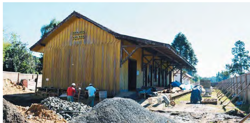
Fotógrafa Fátima Santos está acompanhando as obras de restauração e registrando em imagens
