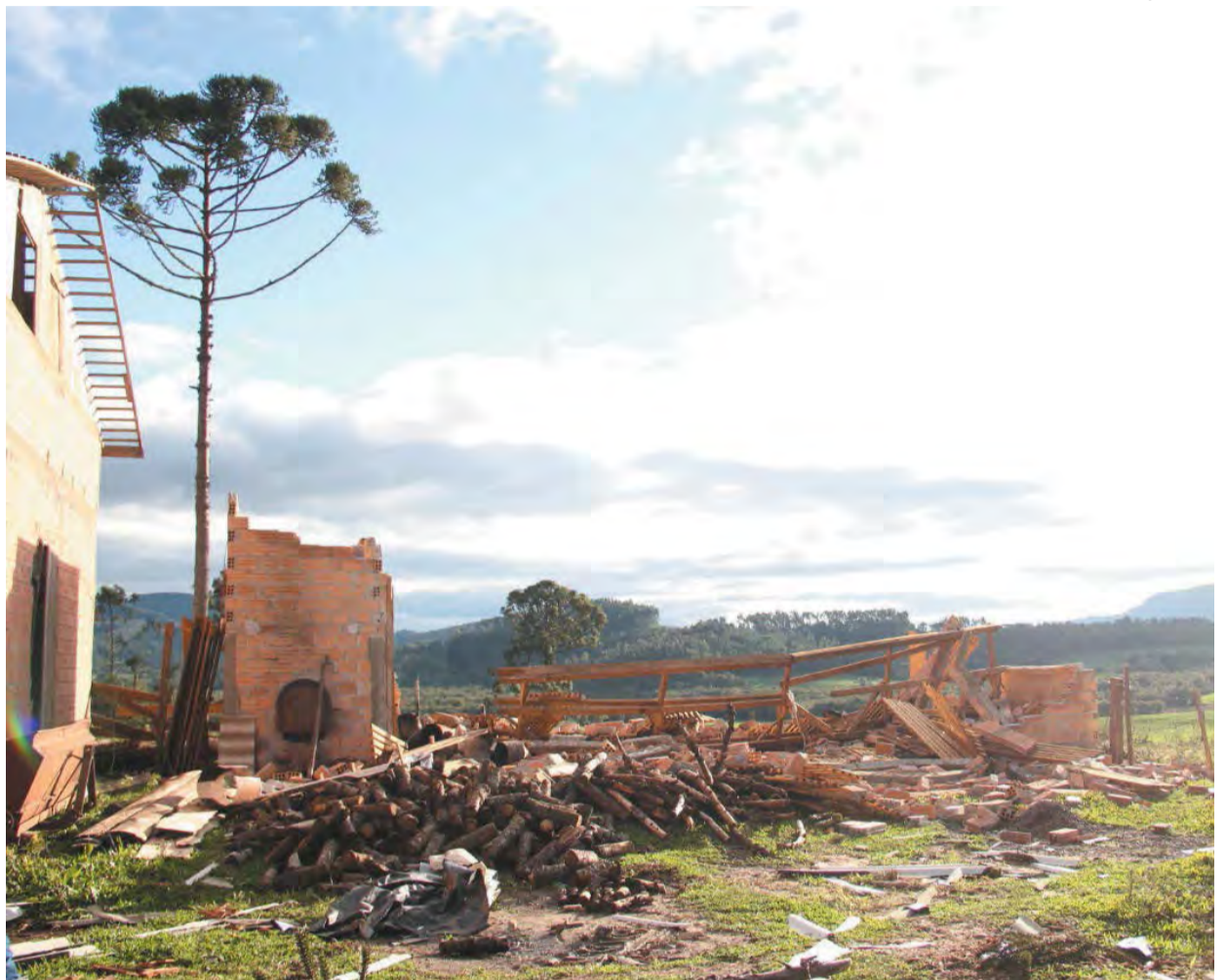
Estufa de fumo foi totalmente destruída na localidade de Pedra Branca, em Irineópolis
