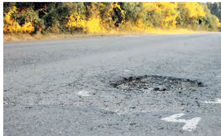
Buracos mais profundos estão assinalados ao longo da rodovia e devem ser os primeiros a serem reparados na próxima obra de medidas paliativas
