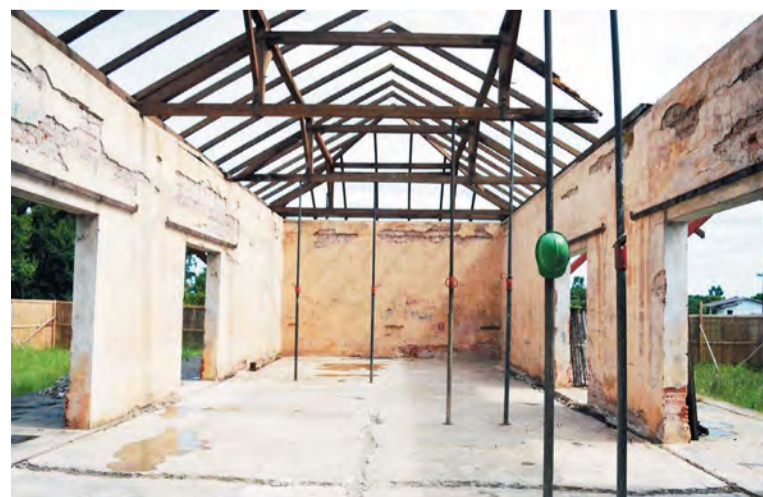
As telhas e portas do armazém já foram retiradas
