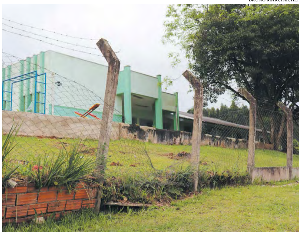
Cerca que está arrebitada será arrumada após as reformas no interior do CEI
