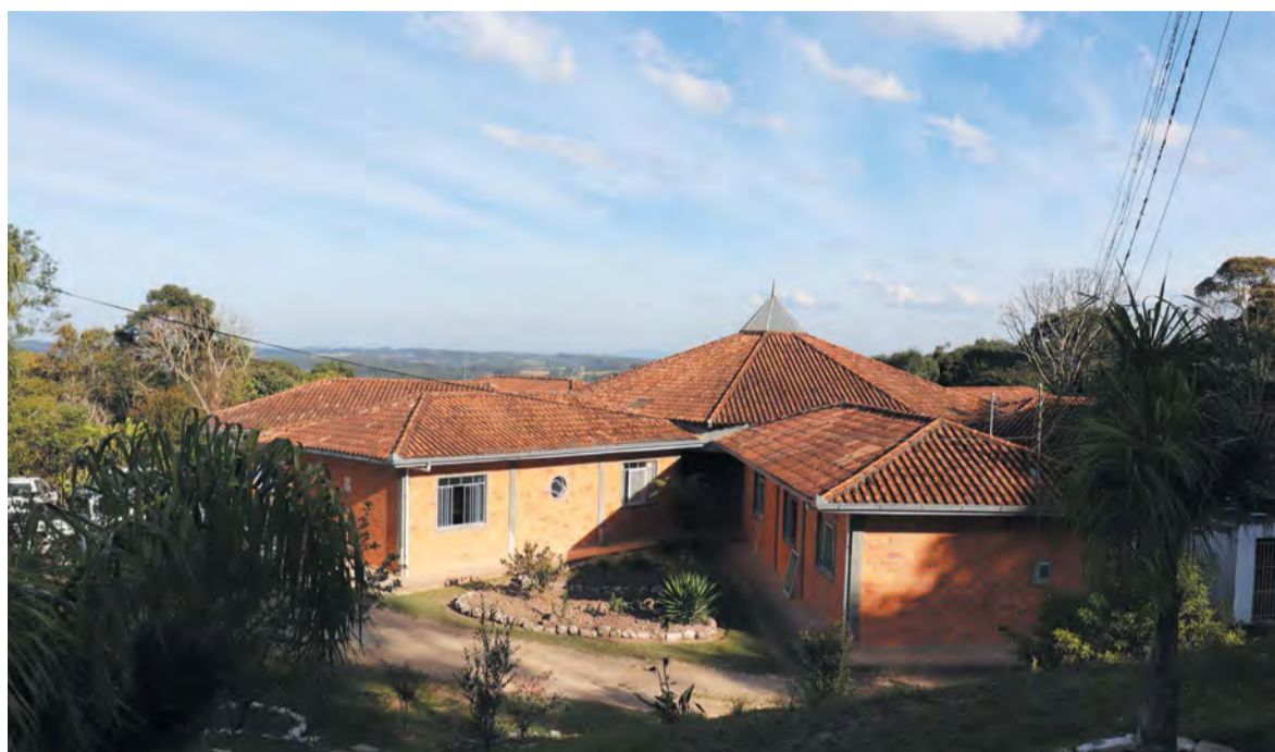
A construção da casa é em forma de Sol
