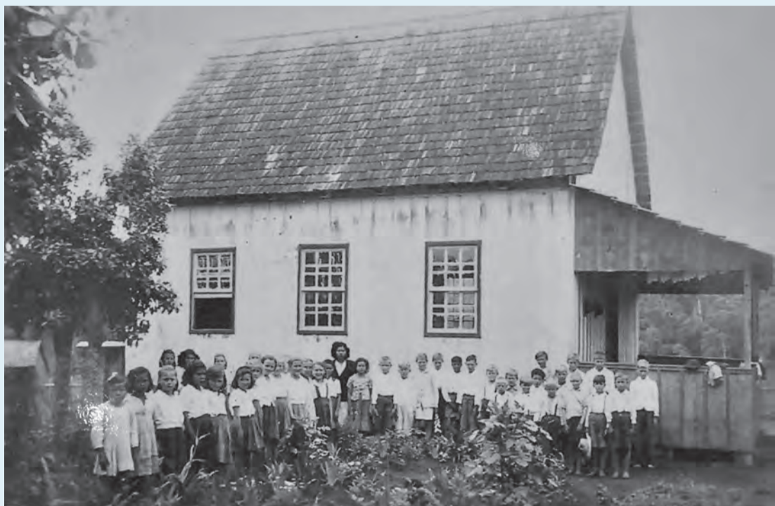
Em Irineópolis, professora e estudantes posados para a foto. Note-se a cobertura da escola, feita com tabuinhas de araucária.
