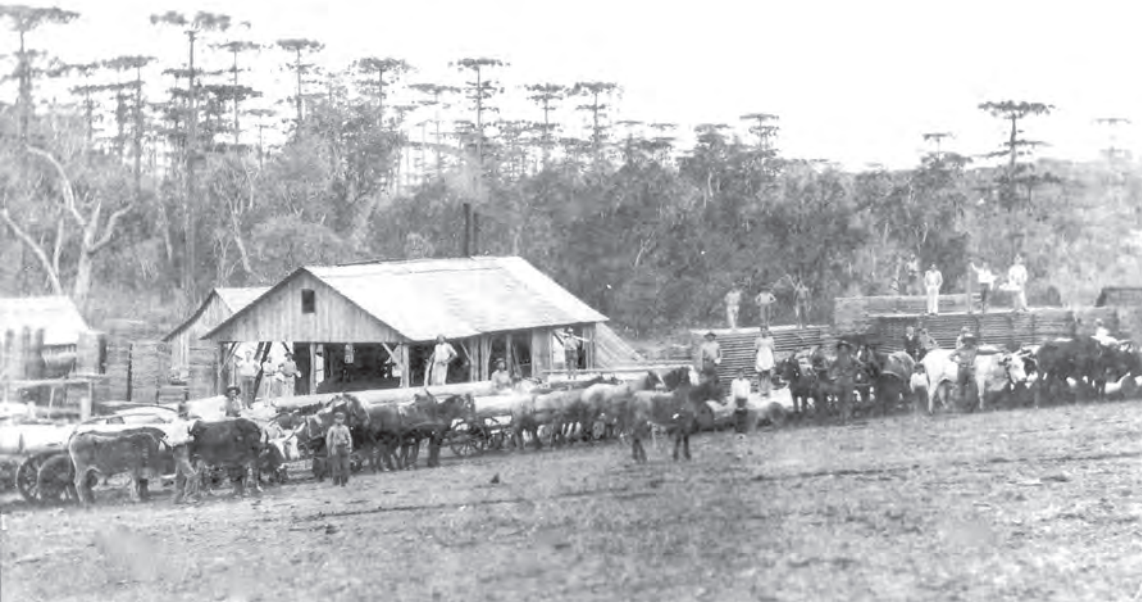
Em lugar que não consegui identificar, uma das tantas serrarias do interior de Canoinhas. Nota-se os carretões tracionados por bois e cavalos.
