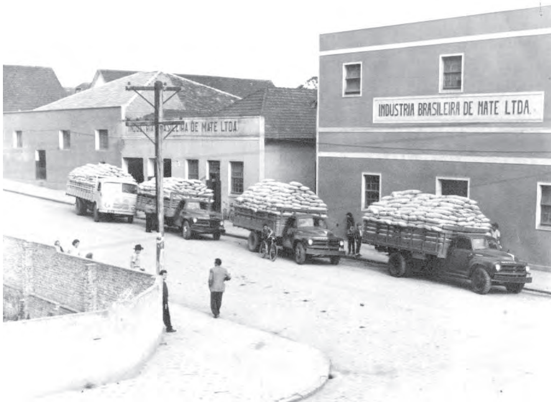
Na Rua Felipe Schmidt, possivelmente ao final da década de 1950, caminhões carregados de erva-mate.
