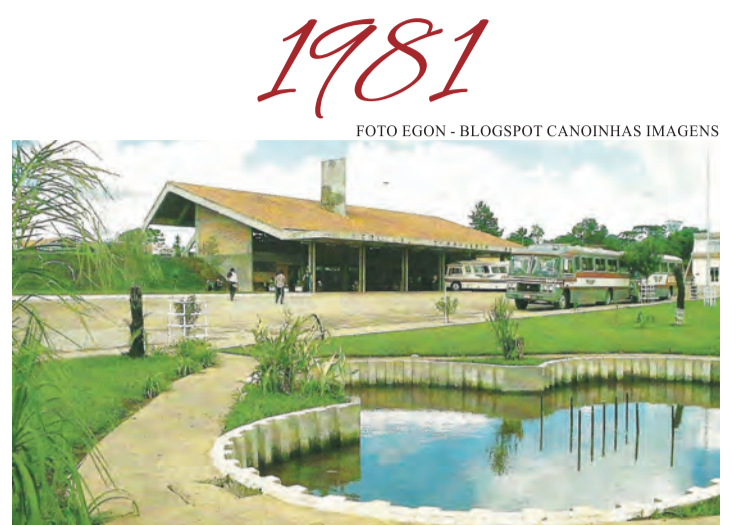
Inauguração do novo terminal rodoviário municipal.
