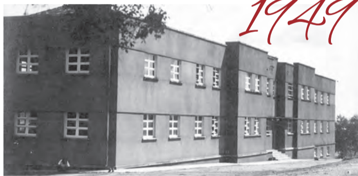
Construção do quartel do 3º Batalhão de Polícia Militar do Município
