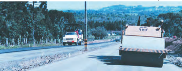
Obras do asfalto na década dos anos 2000
