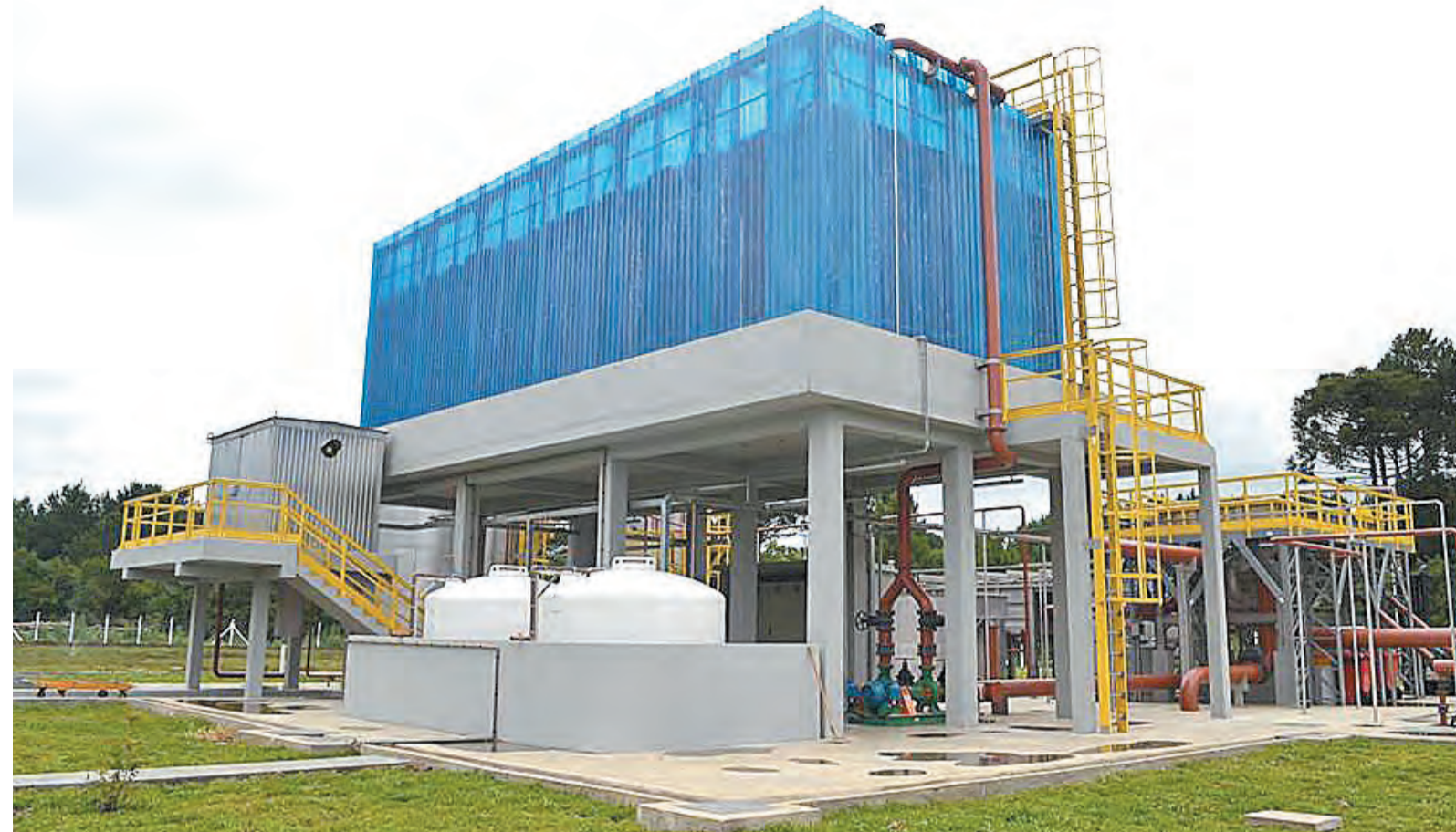
Estação de Tratamento de Esgoto (ETE) em Canoinhas
