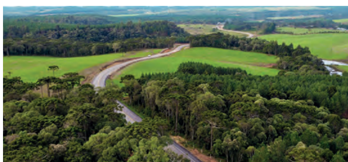
PAVIMENTAÇÃO DA SC-477, ENTRE PAPANDUVA E DR. PEDRINHO
