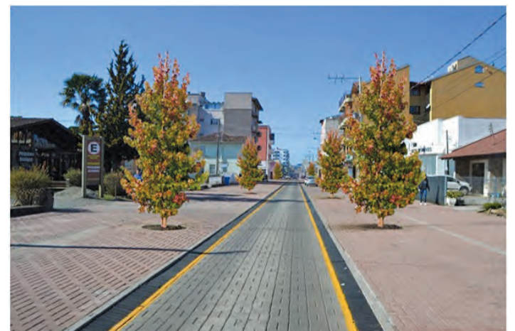
Centro da cidade de São Joaquim, recentemente entregue à população
