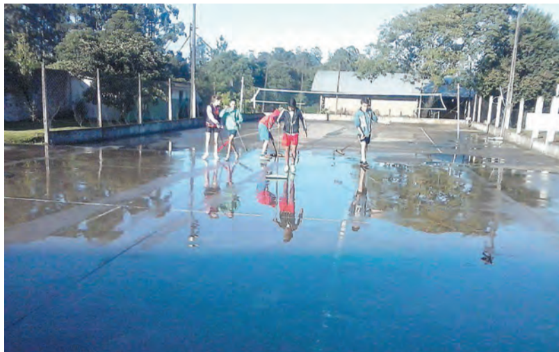
Única quadra disponível no colégio fica inundada após as chuvas
