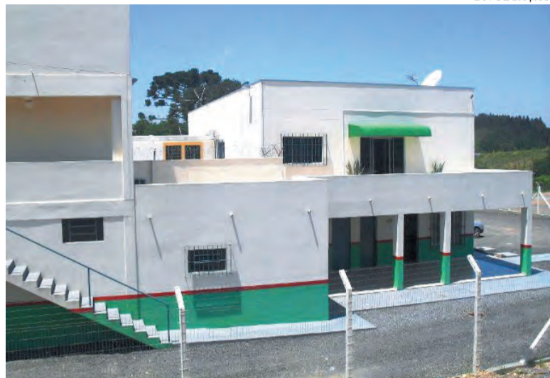
Unidade possui capacidade para 72 detentos, mas, atualmente, abriga mais de 150 internos
